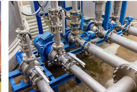
INDUSTRIELLER ROHRLEITUNGSBAU INDUSTRIAL PIPING
